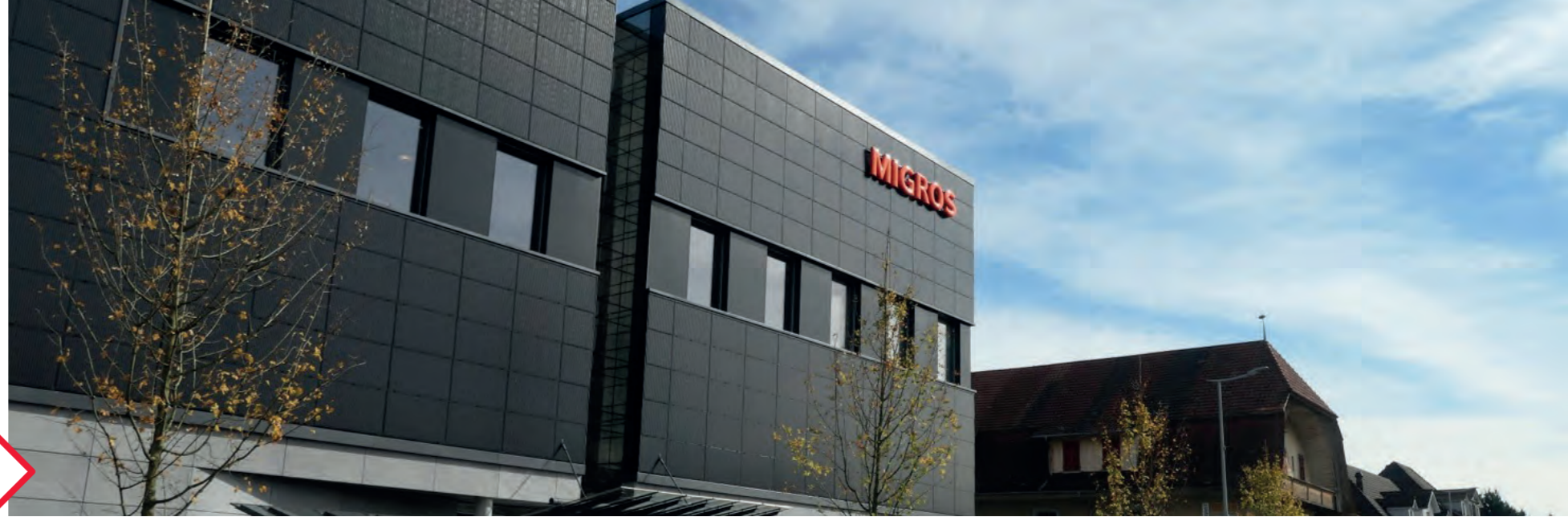
Fassaden-PV-Anlage der Migros in Münsingen.
